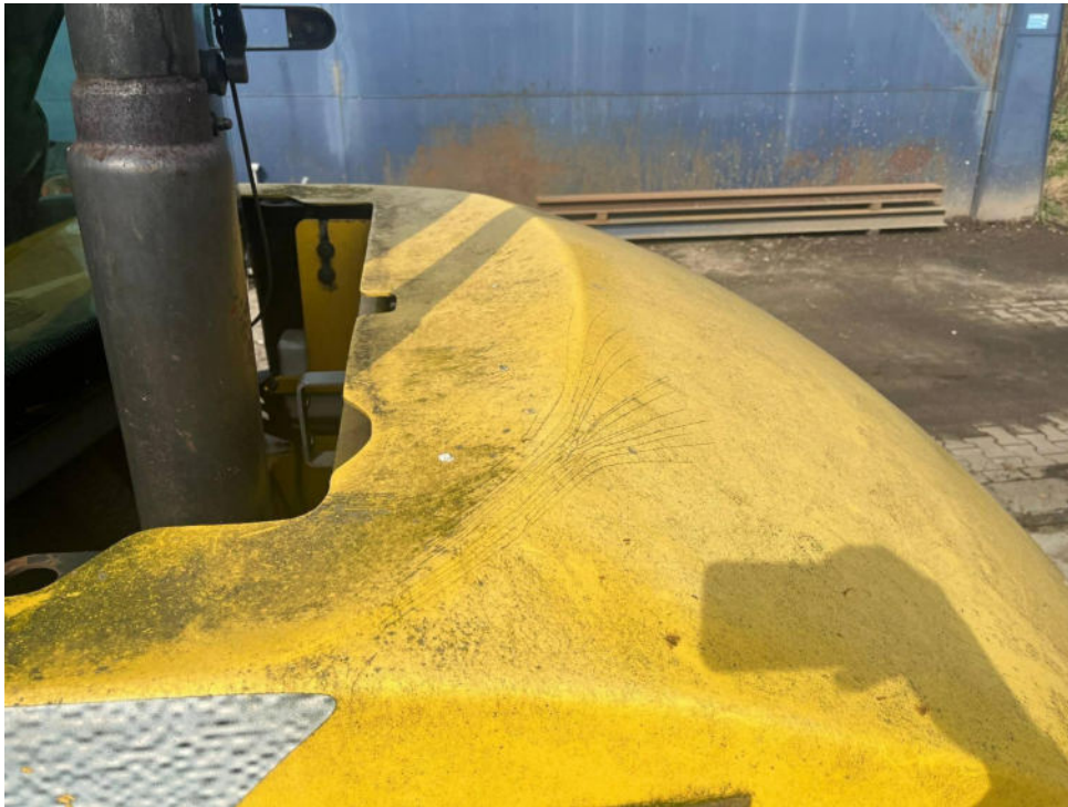
Bild 13 : Motorabdeckung hinten Rissig
