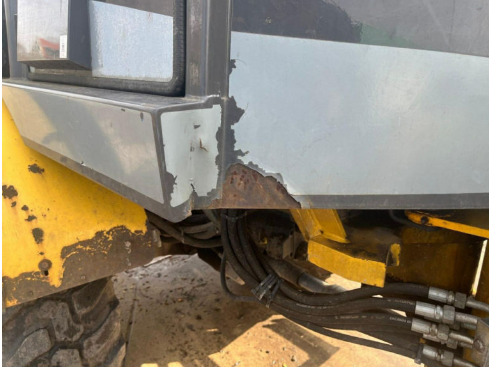
Bild 19 : Aufbau ringsum verschrammt, teilweise Korrosionsbildung
